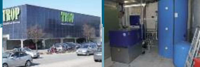
Best Practice in Tirol: Trop in St. Johann setzt auf nachhaltige Maßnahmen, um seine Kosten zu senken. Das gilt auch für die Spitzhüttl Home Company. Ein wichtiger Faktor im Energiekonzept ist das Blockheizkraftwerk (BHKW).
